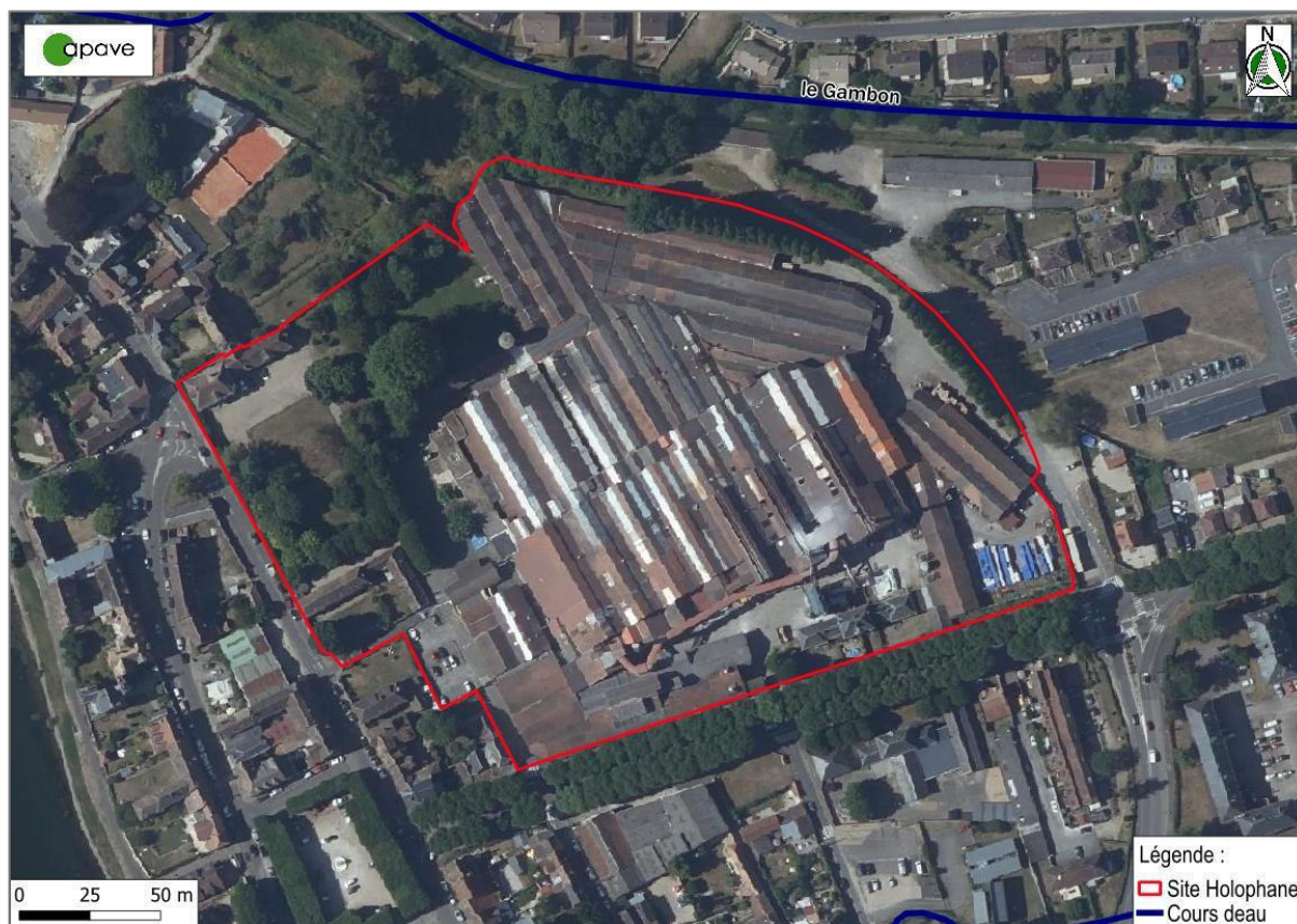
Figure 7 : Présentation du site (périmètre prestation) et de son environnement immédiat (Photographie aérienne / source Géoportail)
